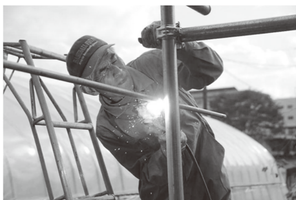
図28 雨よけトンネルの骨格組立
