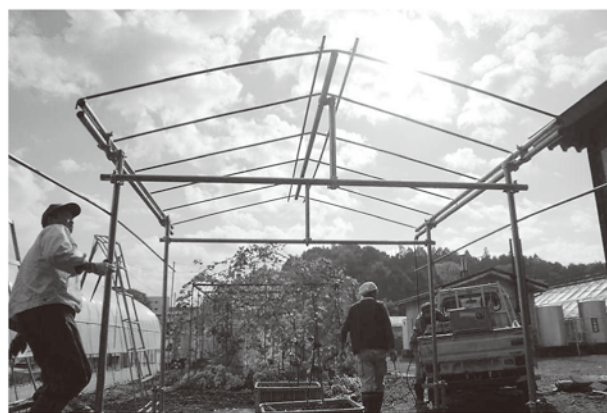
図29 雨よけトンネルの骨格全景
