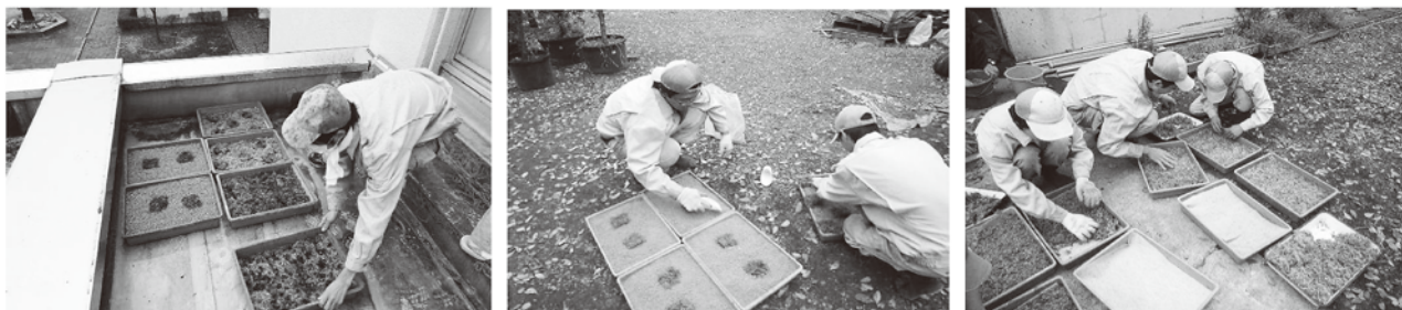
図11 屋上緑化の施工実習の様子
