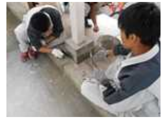
柱基礎の施工
