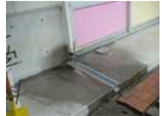
グレーチングの設置
