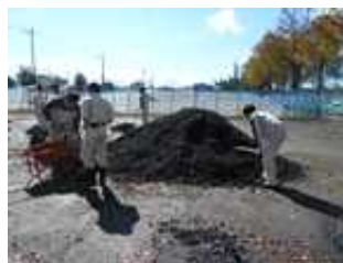
砂利の敷均し
