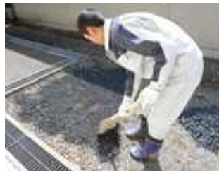
砂利の敷均し
