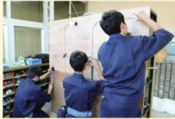
電気工事実習
