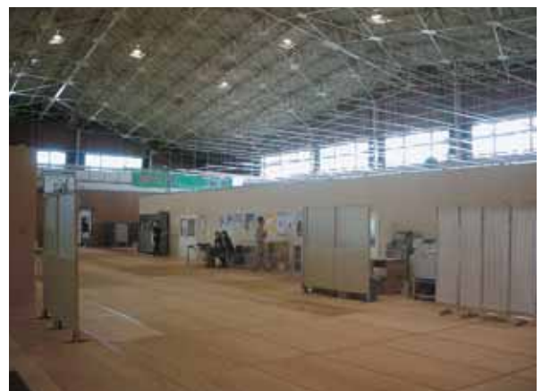
工事中 仮校舎 (第2体育館)
