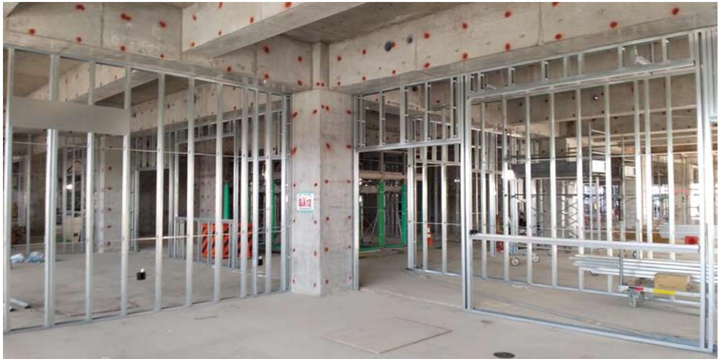
↑ これが足利高等学校の壁の下地。軽量鉄骨（LGS）と呼ばれる軽くて丈夫な部材で骨組みをつくって、この間に断熱材を入れたり、表面に石こうボードで面をつくったり、塗装をしたりすればみんなの知ってる壁や天井の出来上がり。
