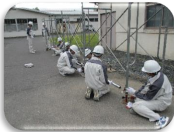
足場組立実習
