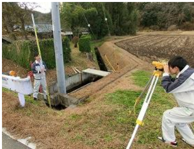
現地(下小代)にて勾配測量
