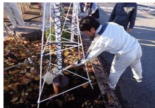
設置作業の様子
