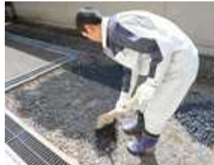
砂利の敷均し
