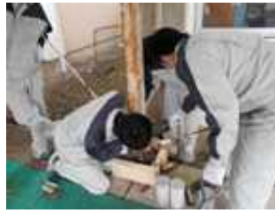
柱基礎の施工
