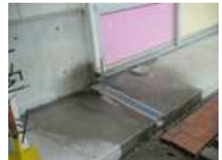
グレーチングの設置
