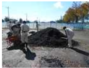
砂利の敷均し
