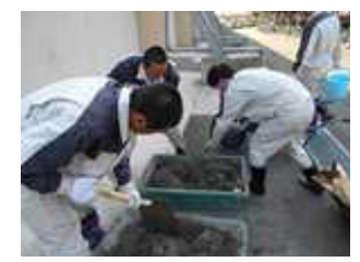
コンクリート練り混ぜ
