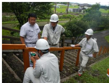
図-8 手すりの改修
