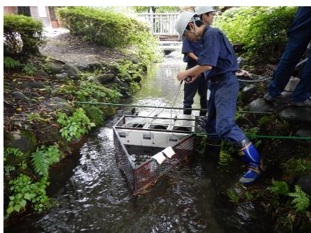
図-5 除塵スクリーン設置
