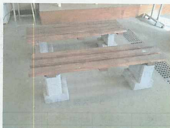
図-3 コンクリートベンチの製作
