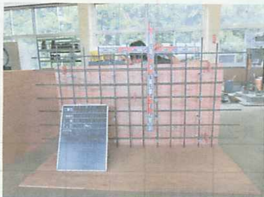
図-1 壁型枠組立と配筋
