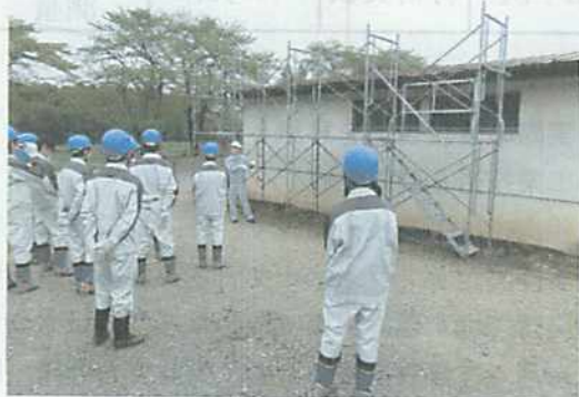
図-2 足場の組み立て
