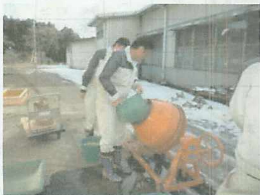
図-5 コンクリート練り混ぜ
