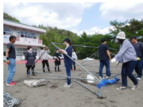
テント骨組みの設営
