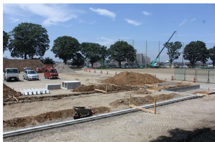
〈排水溝の設置〉
