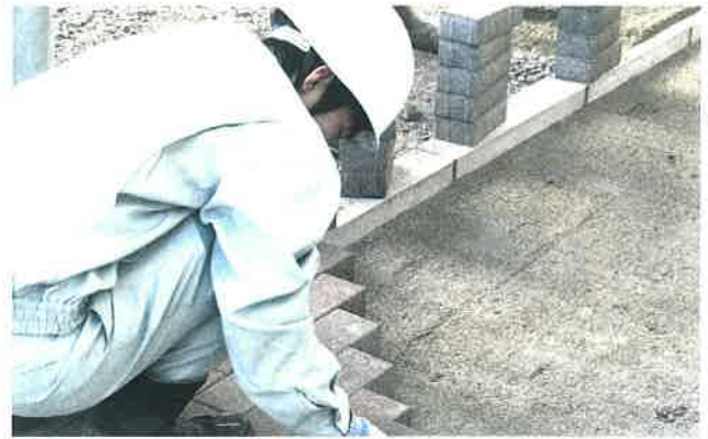
インターロッキング舗装実習
