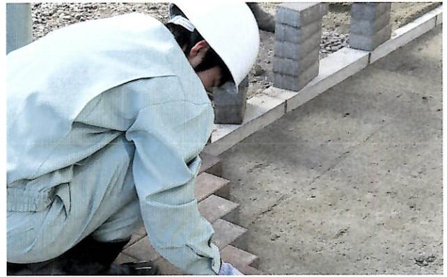
インターロッキング舗装実習
