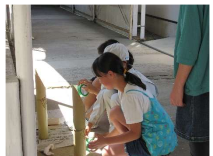
塗装作業①
