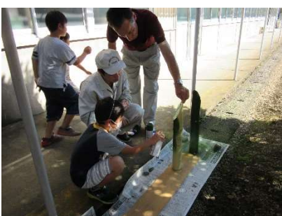
塗装作業②
