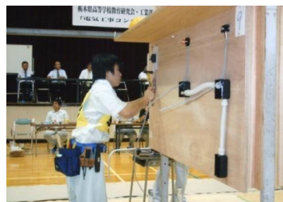
電気工事コンテスト
