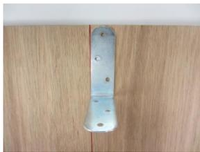
・L字金具を線に合わせて木ねじ2本で固定します。上から力を入れて取り付けてください。
