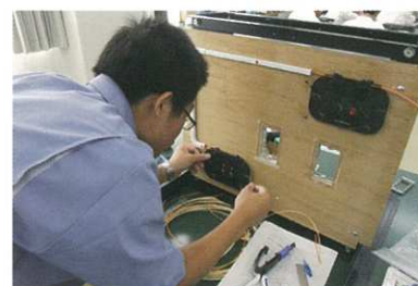
情報配線施工の学習
